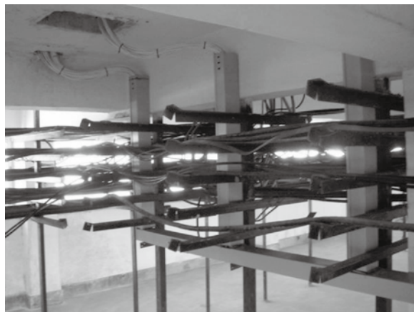
图3 电缆室金属桥架安装后实景图
